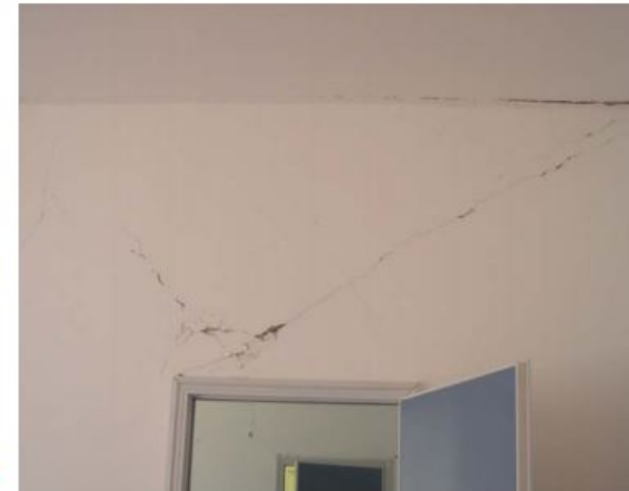
Danneggiamenti al tamponamento: lesioni all'attacco con la trave ed in corrispondenza dell'apertura (*)
