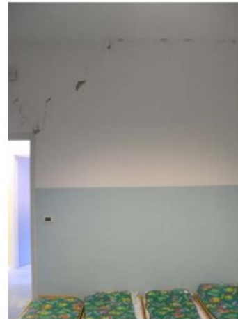
Distacco ed incipiente ribaltamento di una tamponatura in laterizio perimetrale (*)
