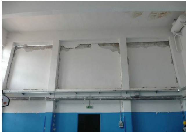
Distacco ed incipiente ribaltamento di una tamponatura in laterizio perimetrale (*)
