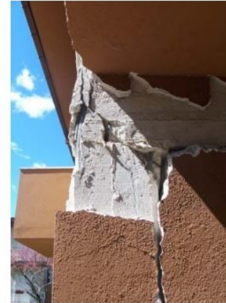
Rottura del nodo perimetrale di una struttura in c.a. (*)
