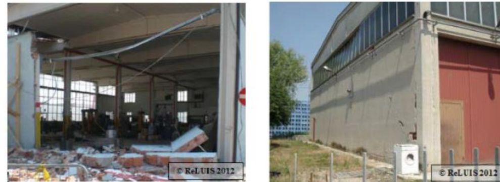
Collasso e fessurazione del pannello di tamponatura in laterizio in una struttura prefabbricata monopiano di recente costruzione (*)
