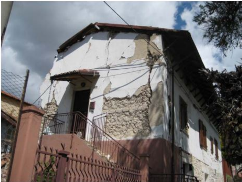
Lesione del cantonale di un edificio in muratura (*)
