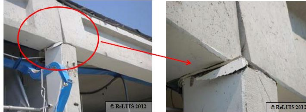
Inadeguatezza del vincolo trave – colonna con danneggiamenti locali del pilastro e rotazioni permanenti della trave in copertura (*)
